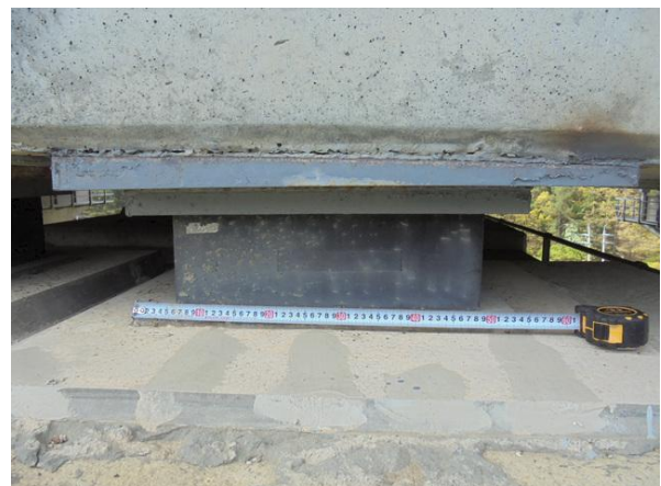
교량받침 이동량 측정
