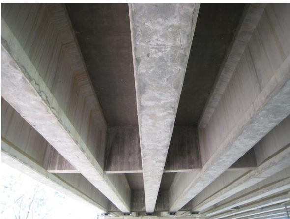
거더 및 바닥판하면 전경
